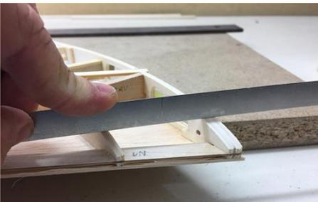
Anschließend passen Sie die Kontur der Rippen im vorderen Bereich der Tragfläche dem Profilverlauf an. Verwenden Sie hierfür auch die angefertigte Schleifleiste.
